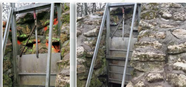
Photos du déversoir de Sadirac avant et après intervention.
