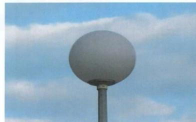
**Remplacement des luminaires équipés de sources SHP (Sodium Haute Pression).** Certains de ces appareils peuvent être, de part de leur ancienneté, en mauvais état car en fin de vie. Souvent de puissances élevées, leurs remplacements par des lanternes à leds permet de faire des économies d'énergies en baissant les consommations.
