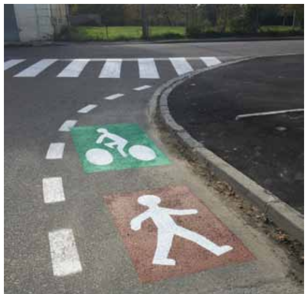
Voie réservée aux piétons et aux vélos, à l'angle du chemin de Lagrange et de la route de Morillon.
